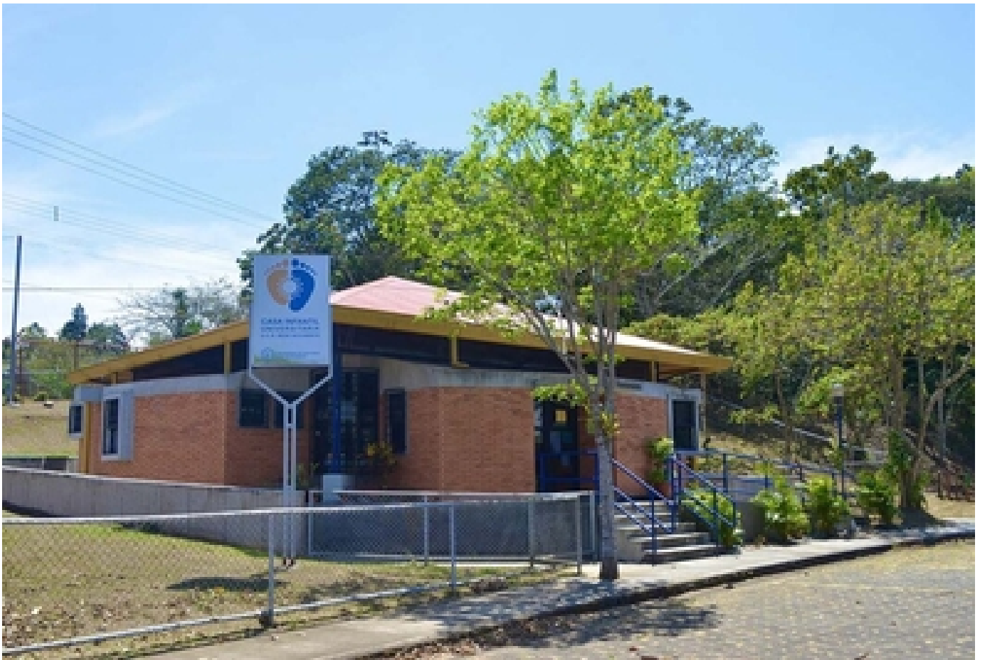
Este es el edificio de la Casa Infantil niversitaria de la Sede de Occidente.
