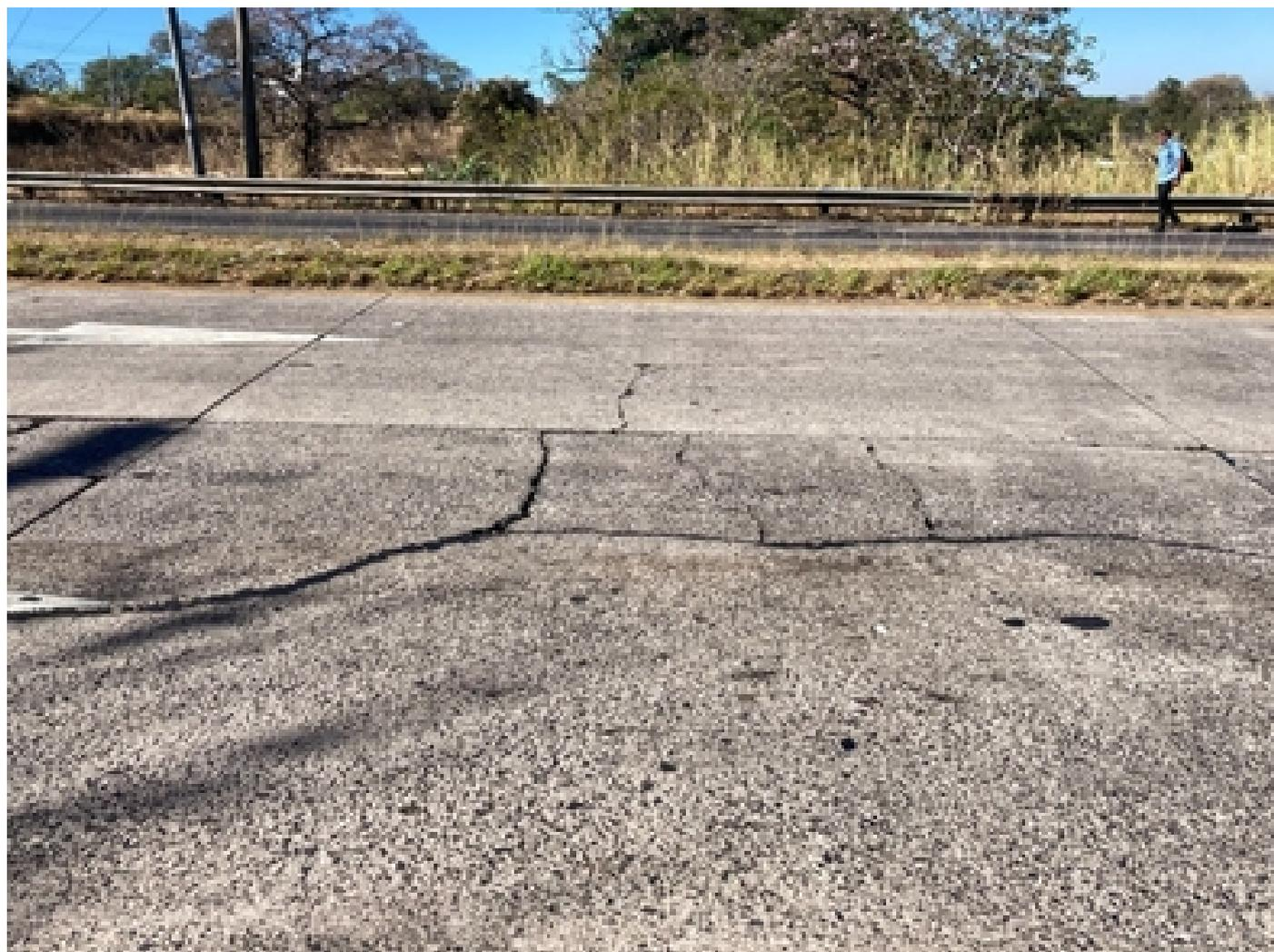
El agrietamiento lineal y transversal en las losas, la losa dividida, la grieta de esquina y el desprendimiento de agregados están dentro de los problemas más recurrentes en la Radial Alajuela. Foto LanammeUCR.
