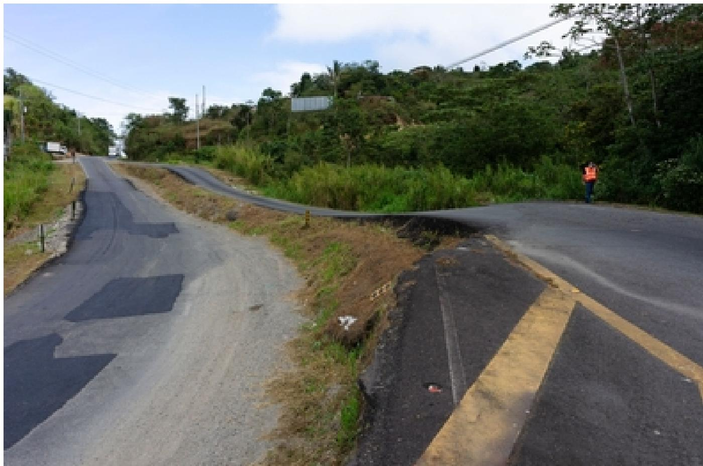
El equipo de profesionales del LanammeUCR identificó zonas de la Ruta 1 que presentan problemas de estabilidad de taludes y deslizamientos que atraviesan la carretera. Foto cortesía LanammeUCR.
