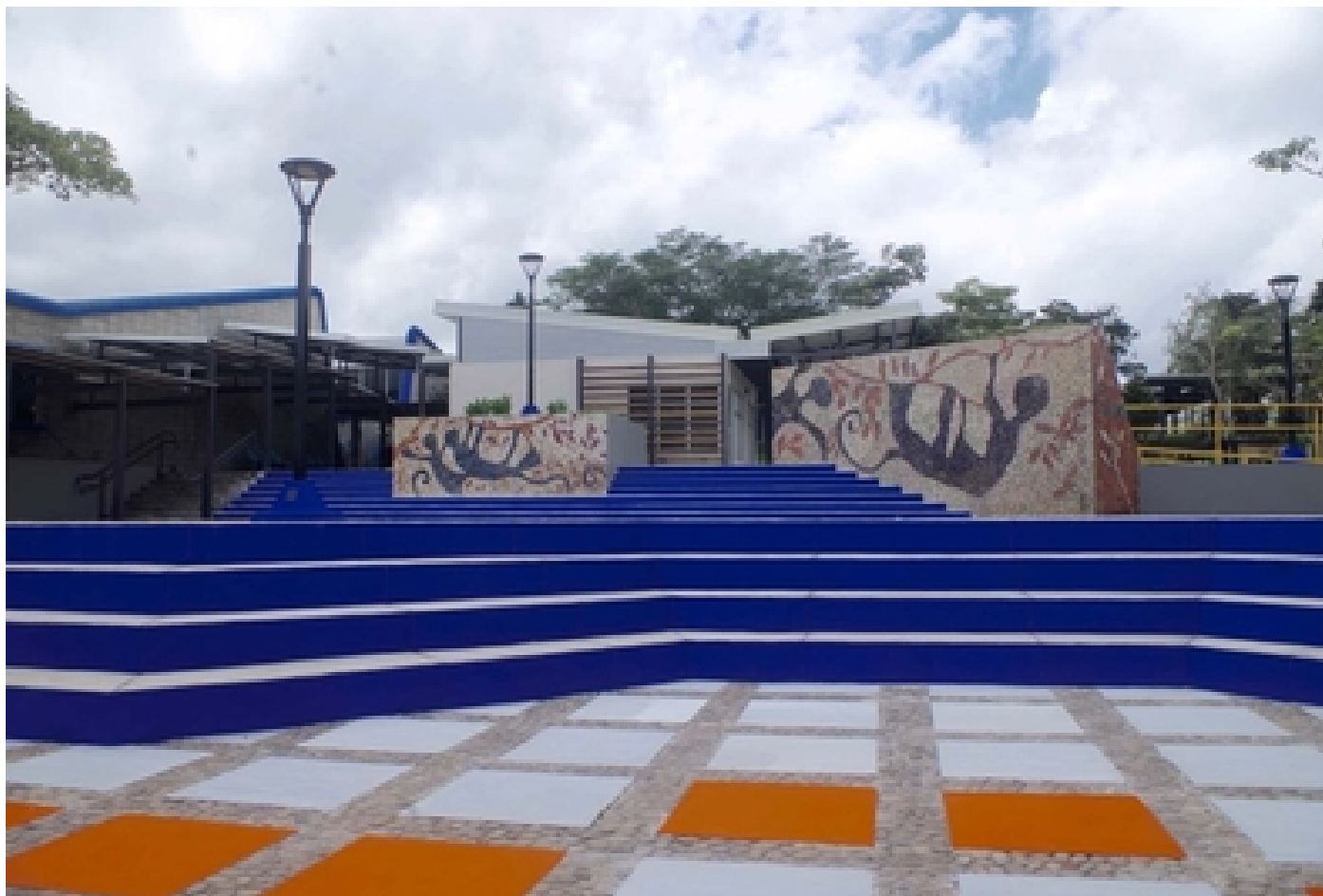
Esta es la plazoleta ubicada entre los conjuntos 1 y 2. Foto Grettel Rojas.
