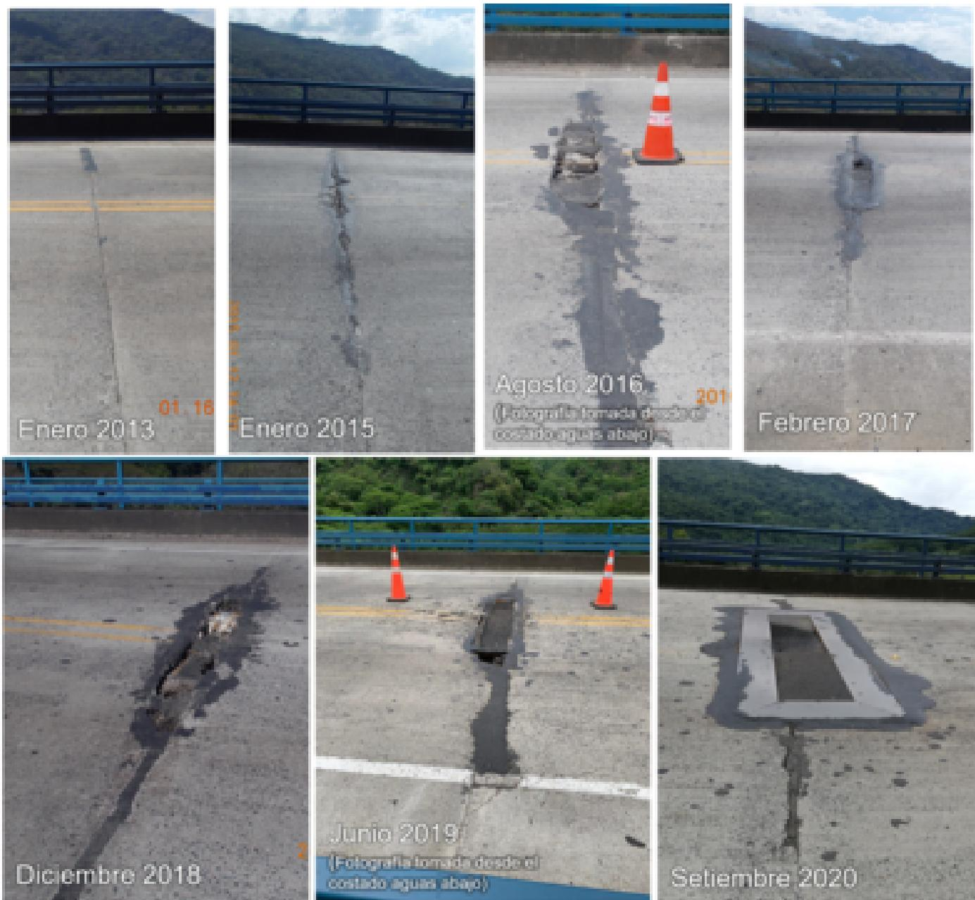
En esta secuencia de imágenes se logra apreciar el deterioro que ha sufrido una parte del puente sobre el río Salitral y el parche que solo ofrece una solución temporal. Foto: cortesía del LanammeUCR.
