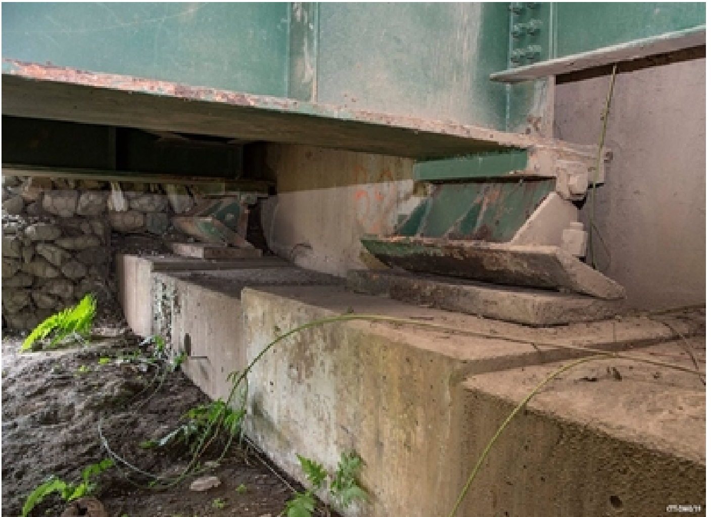
Estructura del puente sobre el río Chirripó en la ruta nacional 32. Foto cortesía LanammeUCR.
