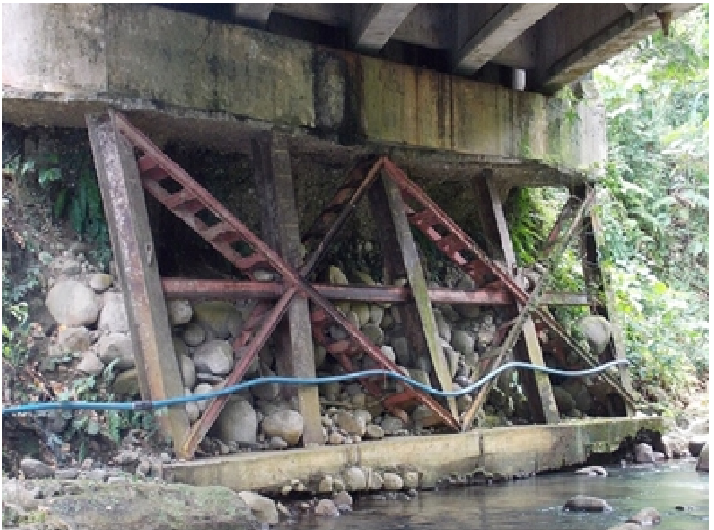
Estructura del puente sobre el río Hondo en la ruta nacional 32. Foto cortesía LanammeUCR.
