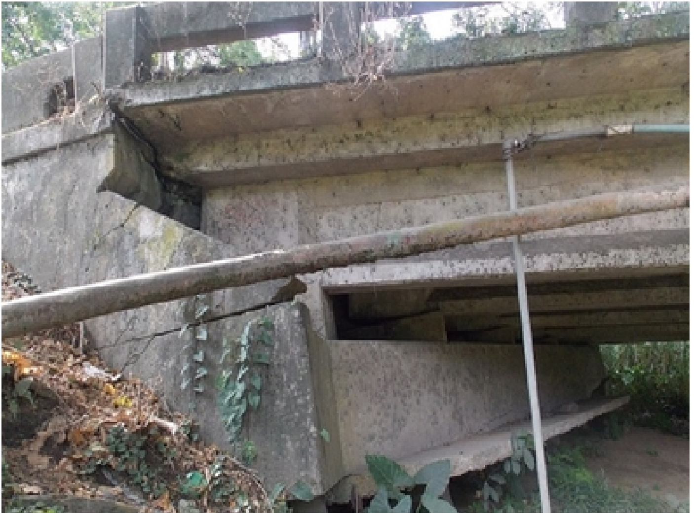
Estructura del puente sobre el río Blanco en la ruta nacional 32. Foto cortesía LanammeUCR.
