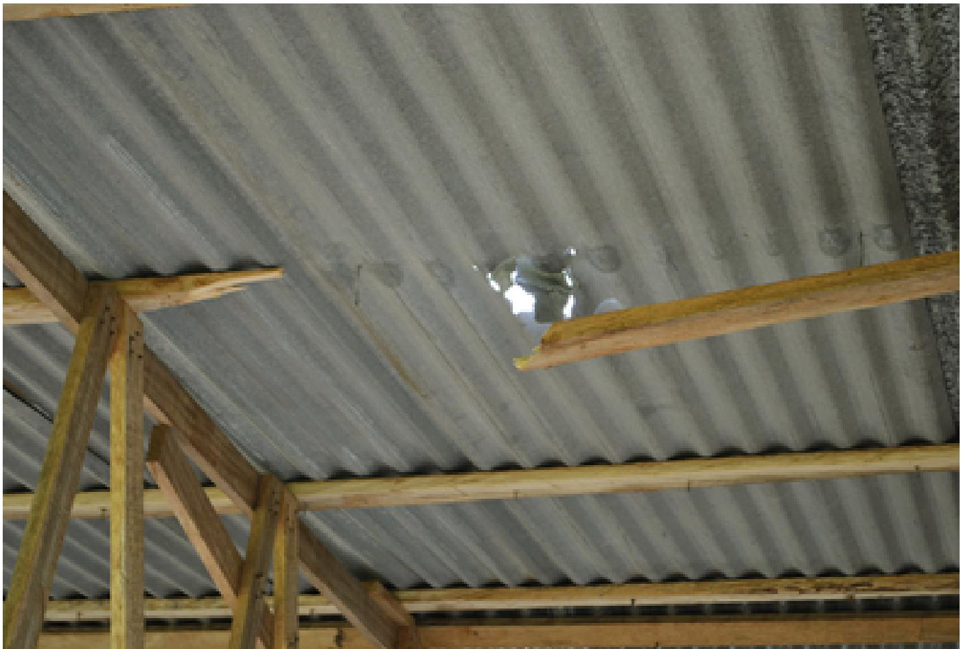
Orificio en el techo y daño a la cercha causado por el fragmento caído en La Caporal de Aguas Zarcas, en San Carlos.
