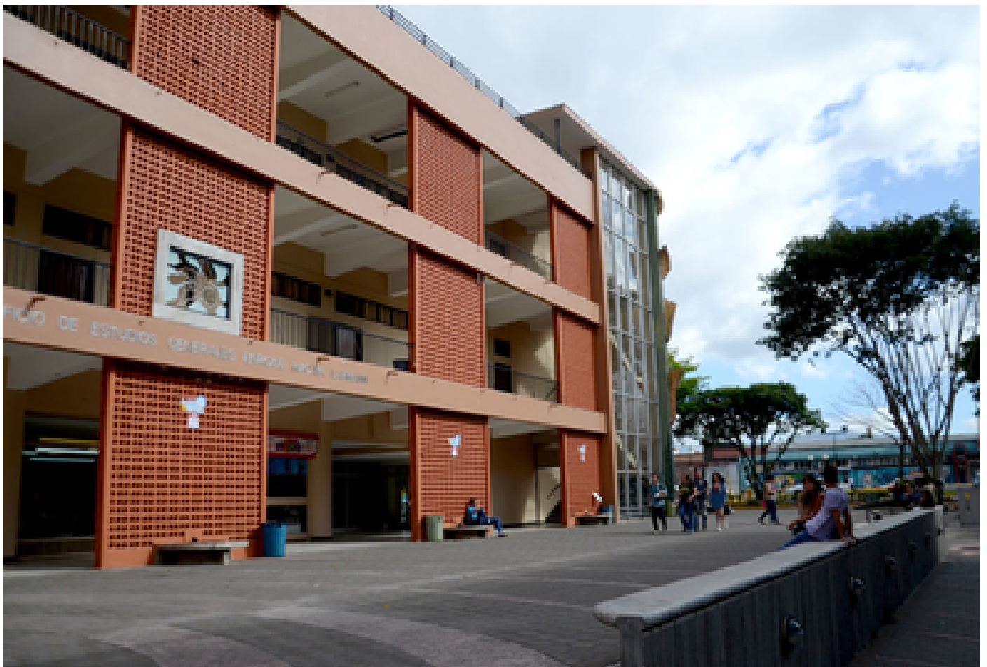
Pretil frente al edificio de la Escuela de Estudios Generales de la Universidad de Costa Rica (foto: Laura Rodríguez Rodríguez).
