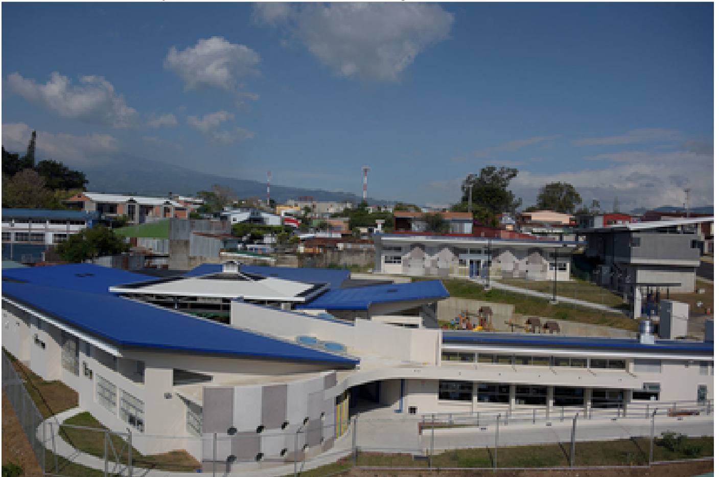
Las nuevas instalaciones del CIL se encuentran frente a la Facultad de Ciencias Sociales, en la Ciudad de la Investigación. Anel Kenjekeeva
