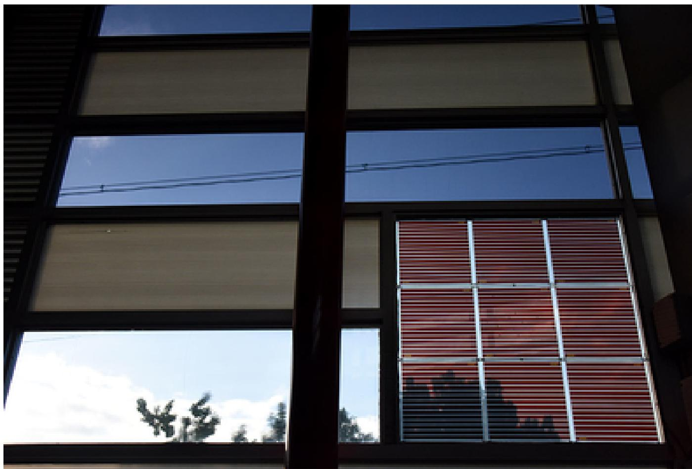
Este conjunto de celdas solares sensibilizadas con tintes, instalados en posición vertical (a la derecha) en la fachada del Centro de Electroquímica y Energía Química (Celeq) de la
