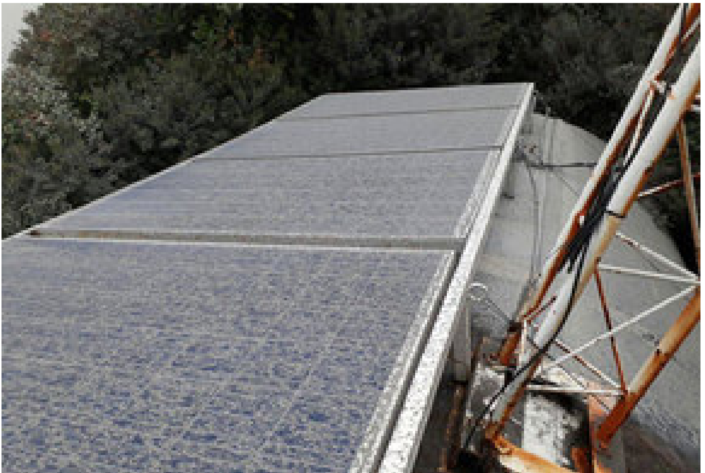
Páneles solares en el Parque Nacional Volcán Poás afectados por la caída de ceniza.(Foto: Dr. Oscar Lucke)
