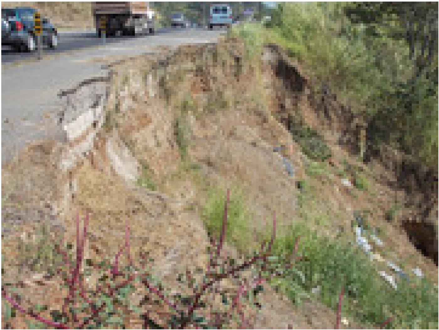
Los especialistas consideran que con el inicio de las lluvias, el agua se infiltra en las grietas del talud que soporta el pavimento y puede provocar nuevos deslizamientos (foto Lanamme).
