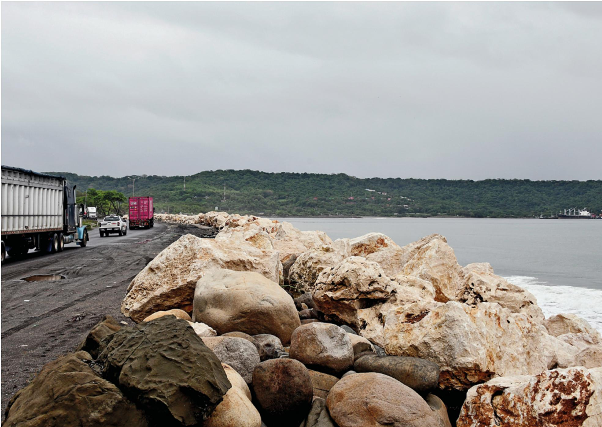
Las soluciones de la UCR para mejorar la Ruta 23 resaltan la necesidad de construir espigones en el mar para disminuir la energía del oleaje y reducir la erosión costera. Igualmente, señalan la importancia de contar con sistemas de monitoreo y datos sobre las condiciones del mar, además de una adecuada señalización vial de la carretera. Foto: Laura Rodríguez.
