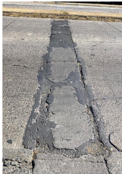
Figura 18 Baches con severidad alta, est. 1+070 (imagen de la izquierda) y 1+120 (imagen de la derecha) sentido de venida.
