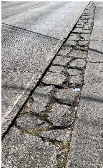
Figura 18 Baches con severidad alta, est. 1+070 (imagen de la izquierda) y 1+120 (imagen de la derecha) sentido de venida.
