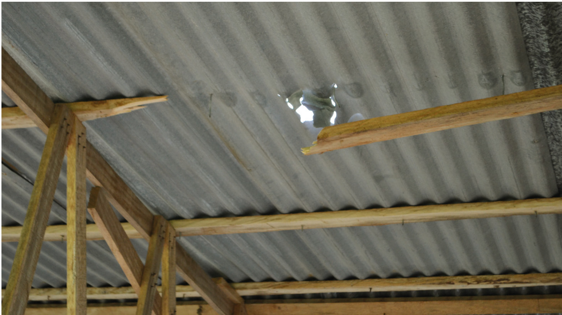
Orificio en el techo y daño a la cercha causado por el fragmento caído en La Caporal de Aguas Zarcas, en San Carlos. Este fue el primer material identificado como meteorito. Foto: cortesía de la Escuela Centroamericana de Geología.
